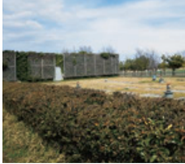
富山県総合運動公園 合併処理浄化槽。
