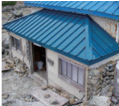
立山・大汝山休憩所トイレ改修。
