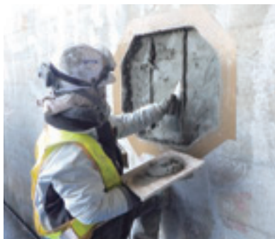
補修・補強工事は目視と手作業で行われている。
